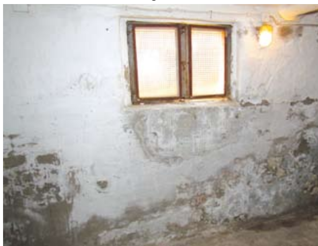
Das Foto zeigt eine für das Östliche Ringgebiet typische, feuchte Kellerwand.
